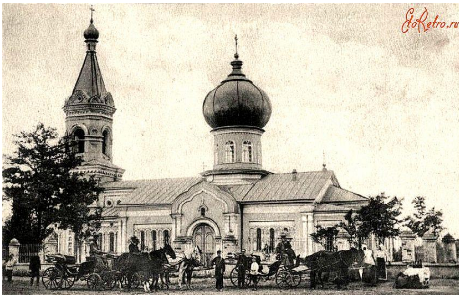
Собор Космы и Дамиана города Грозный был построен между 1850 и 1851 годами. Закрыт и разрушен в годы богоборчества в XX веке. Фото 1910-х годов
