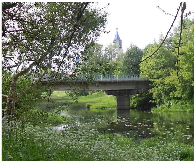
На снимке: Первомайский (Добрынинский) мост. 2016 год.
