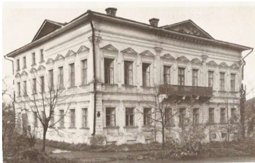
Общественное здание А. П. Дорогутина (ул. К. Маркса, 21). 1870-е гг.
